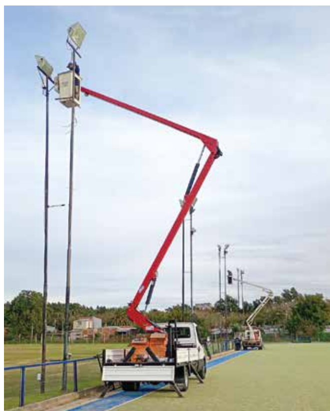
Nueva luminaria para la cancha de Hockey
