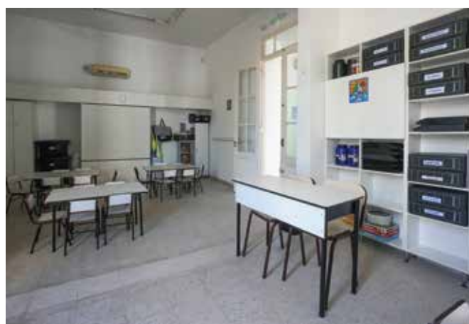
Reacondicionamiento general de las salas
